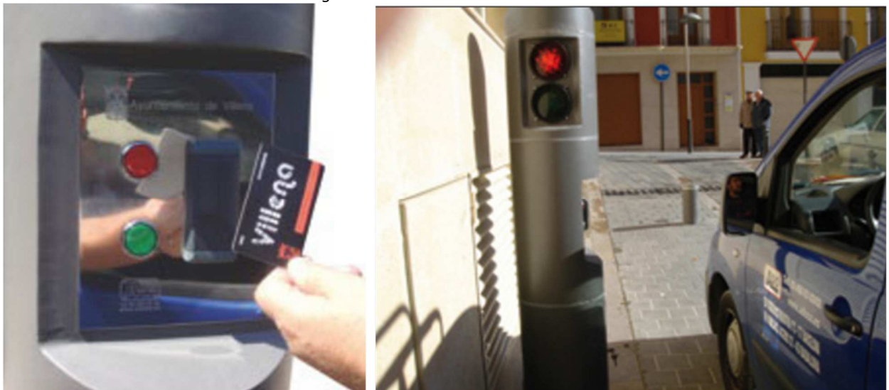
Figura 3. Pals de control d'accessos
