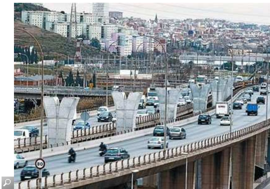
Columnes del viaducte per a bus i vehicles d'alta ocupació emergeixen a la C-58 a Ciutat Meridiana, ahir. RICARD CUGAT
