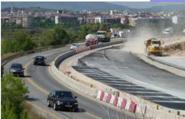
Les obres de l'eix diagonal a l'alçada de Vilafranca del Penedès Foto: A.M.
