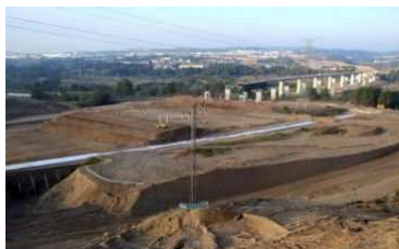
Obres de la Ronda del Vallès
